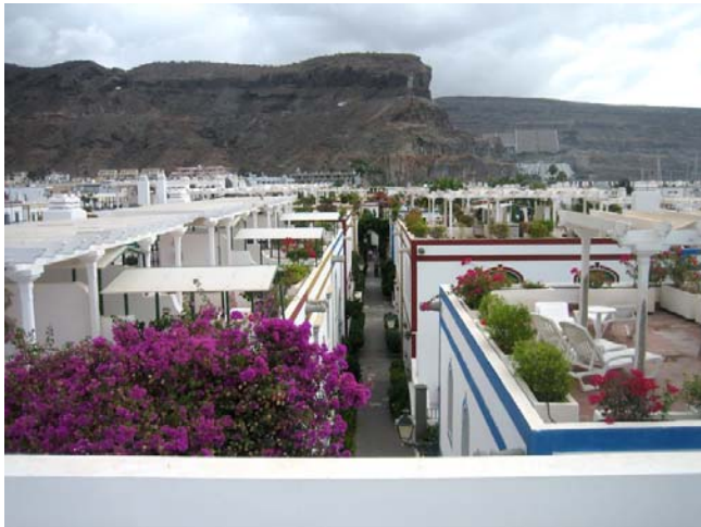
Takterrasser i Puerto Mogán
